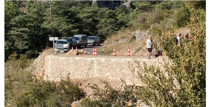
Soutènement routier expérimental en pierre sèche Peyreleau, Aveyron - CD 12
