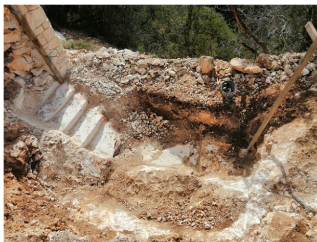
Taille de finition à redans du rocher et création de points d'appui pour les jambages du linteau
