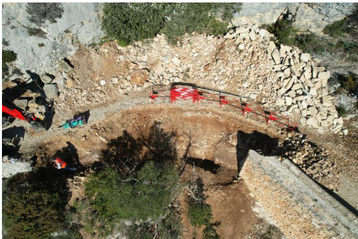
Terrassement en masse et mise à nu du rocher
