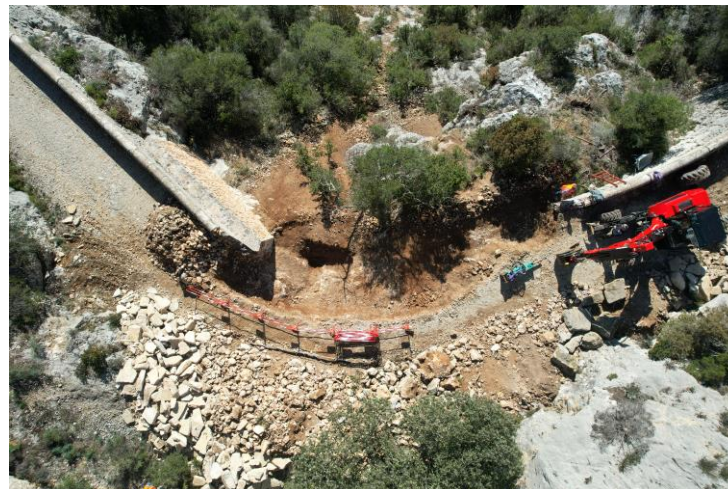
Sondage pour trouver le sol dur en aval de l'ouvrage
